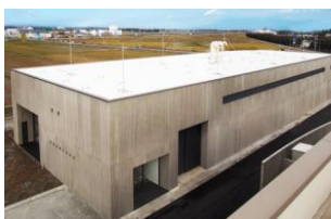
試作研究棟「プロトタイプング・スタジオ」を建設
