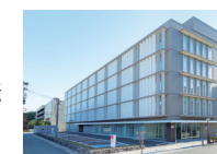
令和3年8月に竣工した 旅籠町ビル
