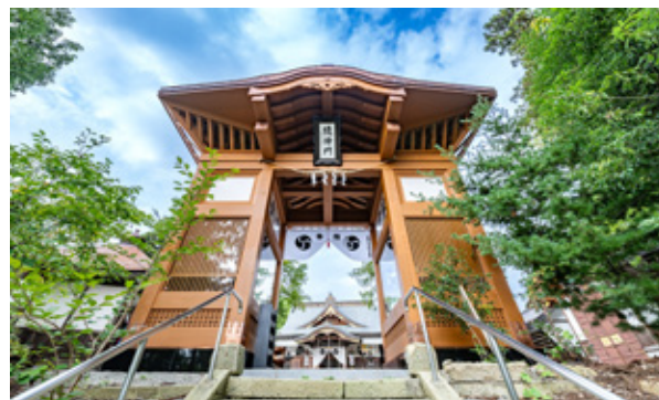
2024年7月に完成した寒河江八幡宮随神門
