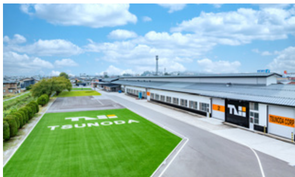
セントラルDCの様子
