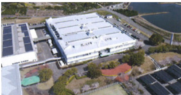
九州工場。左側が2025年新設した太陽光発電設備。
