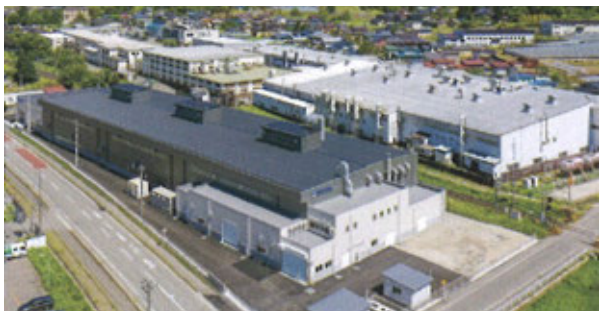
山形工場。手前が2021年新設した塗装工場。
