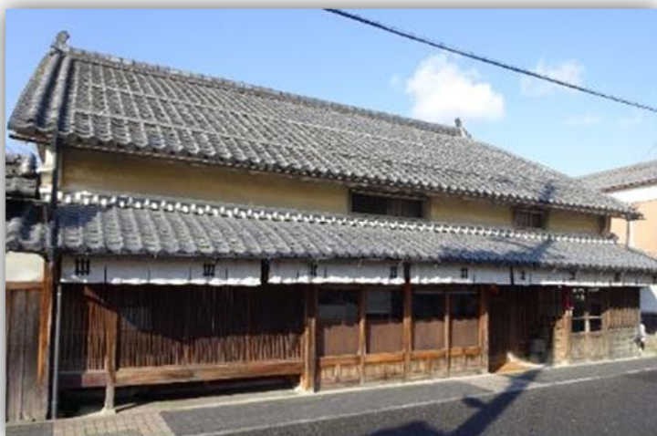
【ONAE 棟：5 棟共通のフロントがある】
